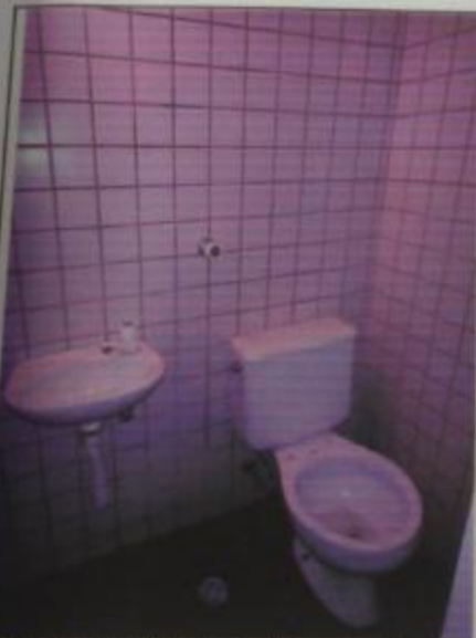
Foto 19 – vista do banheiro de empregada.
