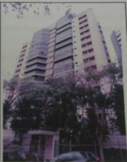
Foto 16 - vista da fachada do condomínio.
