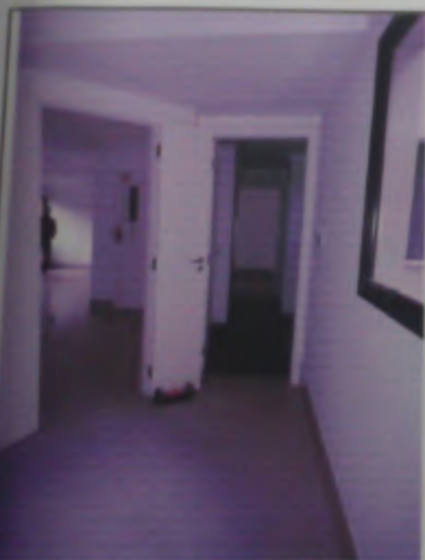
Foto 31 - vista geral do corredor de acesso a cozinha.
