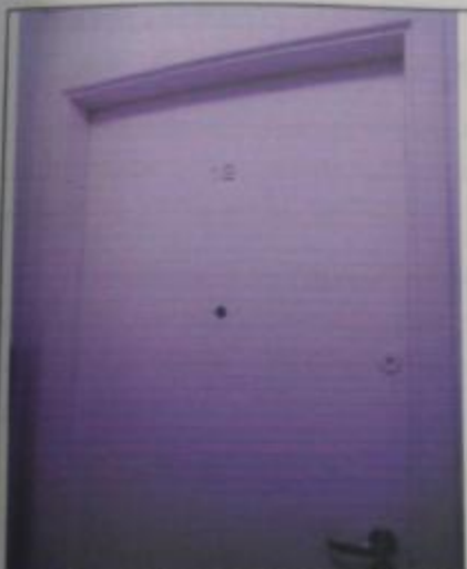
Foto 45 - porta de acesso ao apartamento visitado (nº 12) no hall de serviço.
